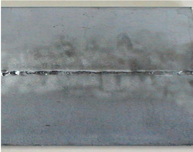
Figura 6: Inspección visual del cordón de soldadura.
