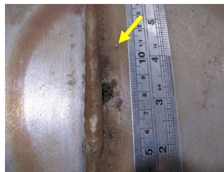
Figura 8. Detalle de picadura. Se indica salpicadura de soldadura.
