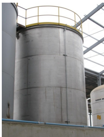
Figura 1. Vista exterior del tanque.
